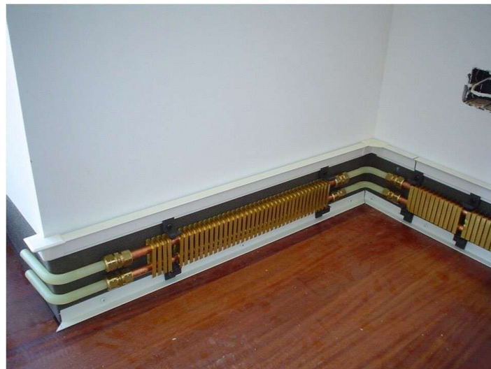
Beispiel 1 für die Sockelheizleiste
