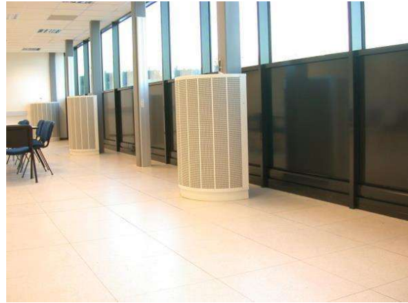
Integration im CERN nach Entfernung der Heizkörper
